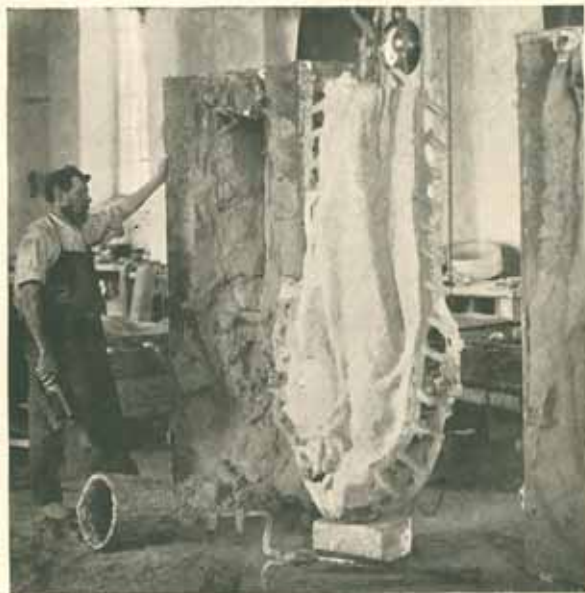
Vyjmání bronzových odlitků z formy v dílně p. Srpka v Brandýse. Květen 1911.
